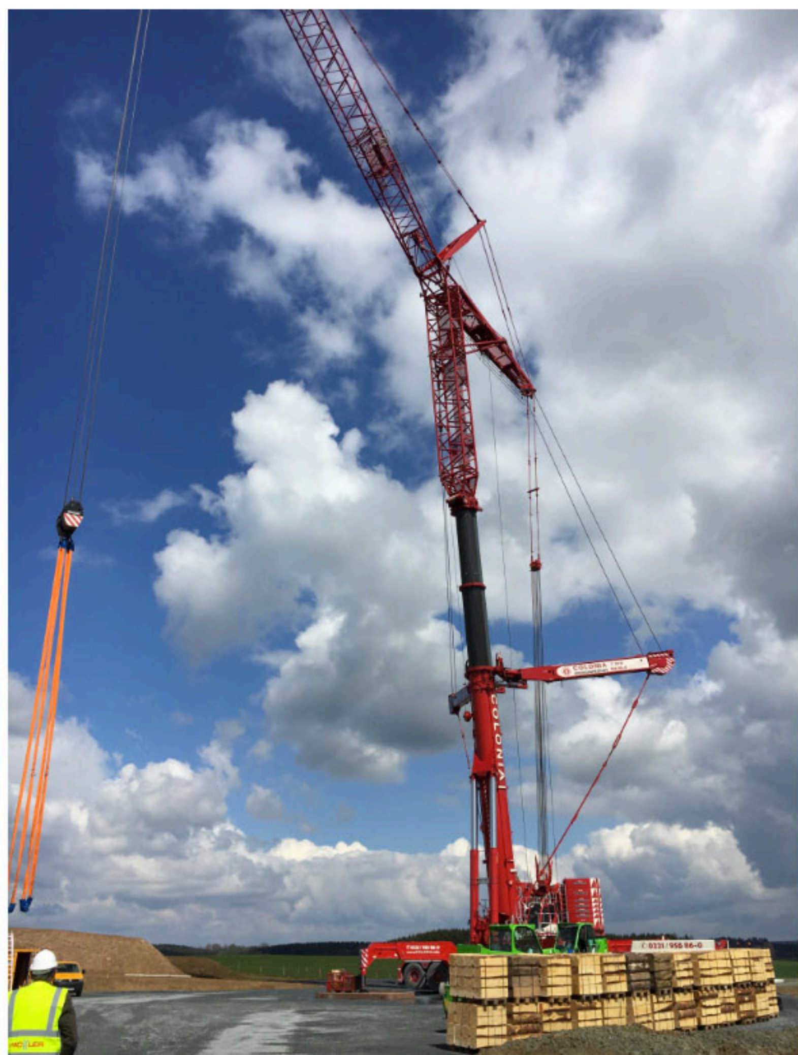
En septembre, la plus grande grue d'Europe arrivera à Weiler pour monter les derniers éléments sur les tours. ♦
